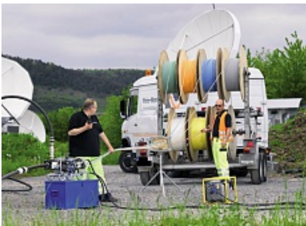
Bild 2-10: Einblasen von Mikrorohren
